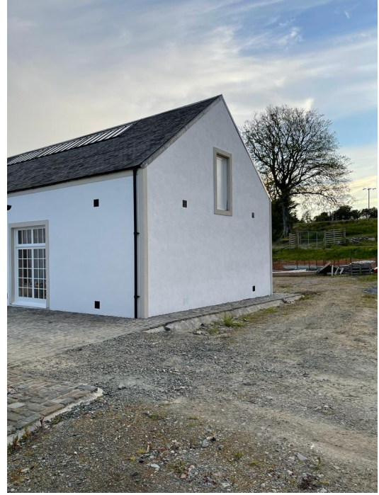
Roof framing overview IMG-20260219-WA0015.jpg
